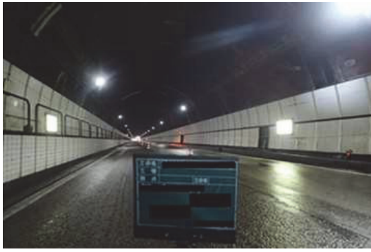
写真-8 覆工表面洗浄前の状況
