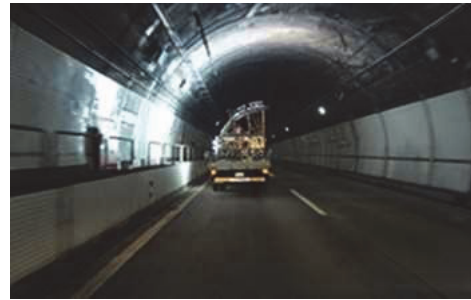
写真-2 覆工表面撮影状況
