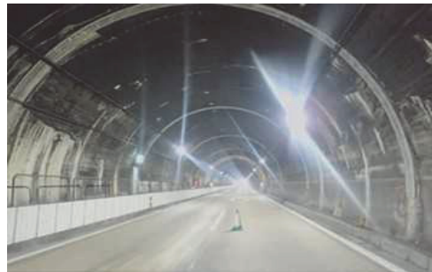
写真-1 供用中の覆工状態 (矢板工法)
