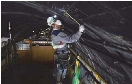
写真-3 近接目視・打音点検状況
