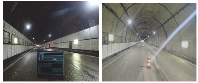
写真-12 覆工洗浄前 (左)・後 (右) の状況
