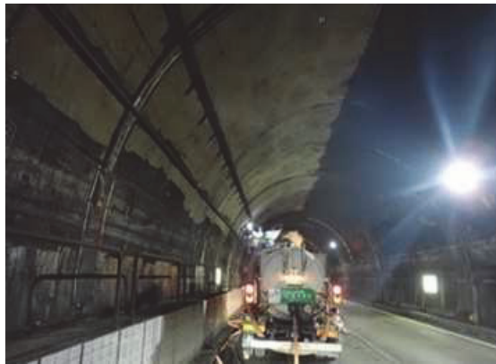
写真-9 洗浄状況 (走行車線側)
